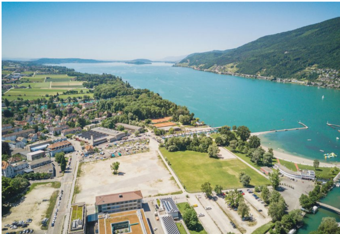
Auch das geplante Quartier Agglolac soll dereinst an das Fernwärmenetz angeschlossen werden. MAKA
