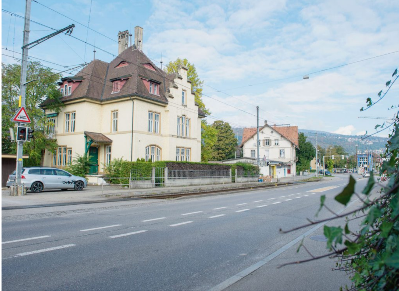
Das Guggerhaus an der Hauptstrasse steht bereits seit rund vier Jahren leer. PETER SAMUEL JAGGI
